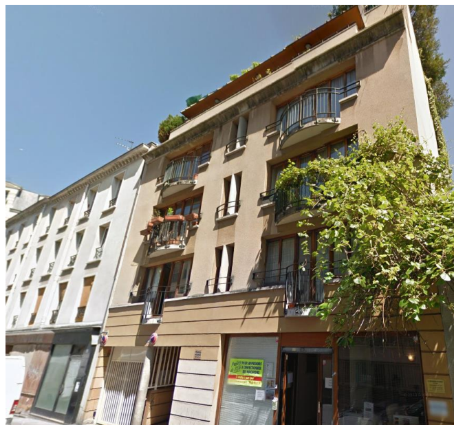
Figure 5 : Photographie du 26 rue des rigoles Paris 20 ème
